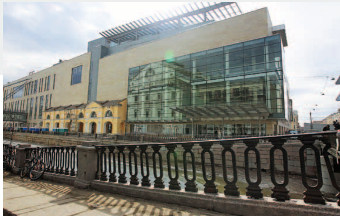
При строительстве зрительного зала Мариинского театра были использованы металлоконструкции, изготовленные на предприятиях «Северстали»
